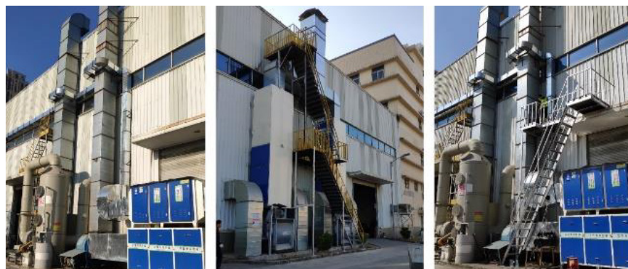
塗裝噴漆廢氣處理設備
